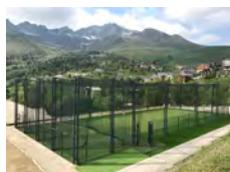
Impact Golf est un équipement durable et écologique composé d'une structure poteau en tubes acier thermo laqués, de filets résistants à l'usure du temps et d'un sol en gazon synthétique ne requérant aucun entretien. Entièrement sécurisée, cette structure est conçue pour permettre aux citoyens et autres personnes éloignés d'un parcours de golf par la distance ou le temps de trajet, de pouvoir s'entraîner sans y consacrer trop de temps. **Catégorie équipement collectif**
